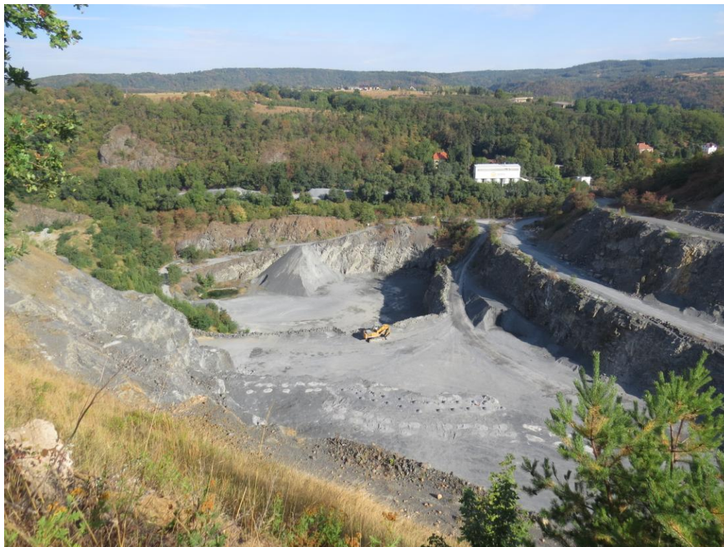
Obr. č. 1. Pohled od JV na 4. a 5. etáž.
